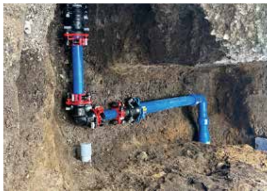
工事後の水道管
