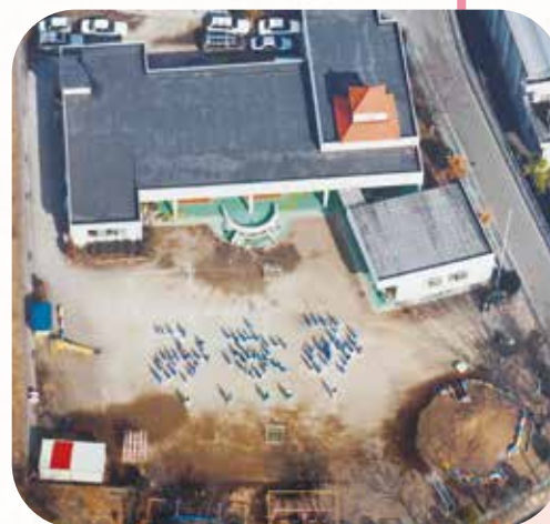
昭和60年3月15日 南幼稚園、新園舎完成
