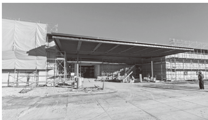
公民館エントランス
