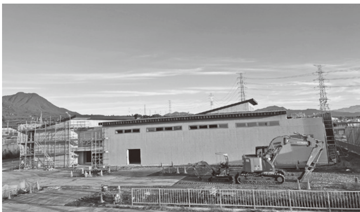
10月末時点の現場の様子。敷地南から撮影。
