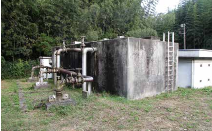
長岡揚水機場
