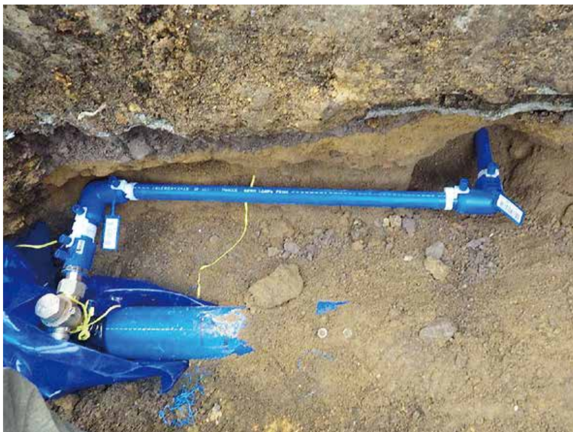
南新井・前橋線道路改良工事に伴う配水管布設替工事
