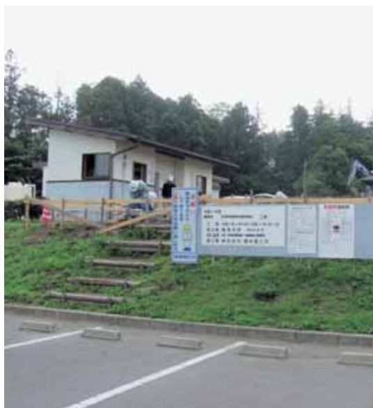
建設中の体育施設管理事務所
