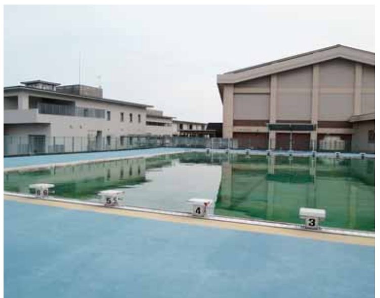
中学校プール
