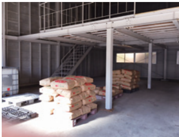
購入予定だった倉庫
