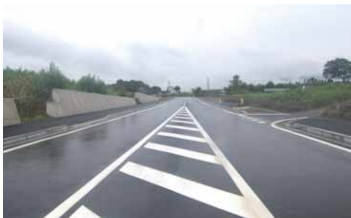
完成が望まれる新保・大藪線改良舗装工事
