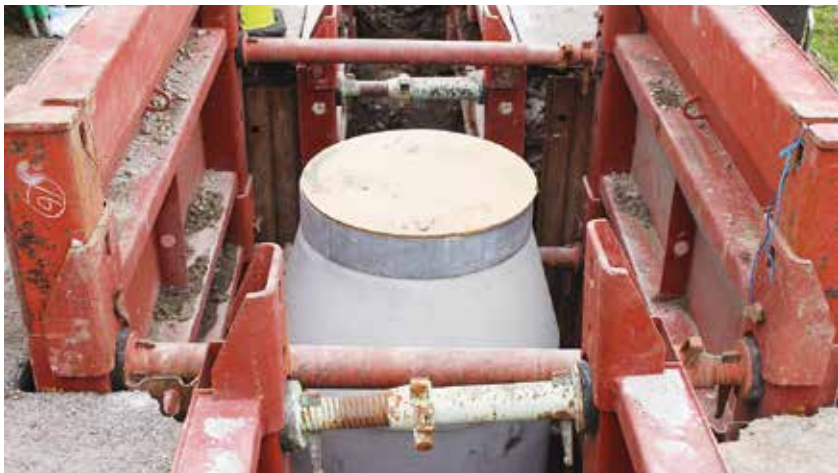
公共下水道事業管布設工事
